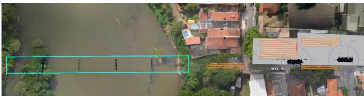
Figura 11 – Posicionamento vigas e treliça
